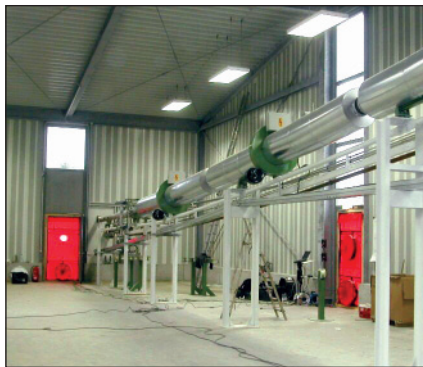
Измерение путем проведения теста BlowerDoor в заводском цехе (источник: БлауэрДоор ГмбХ (BlowerDoor GmbH))
