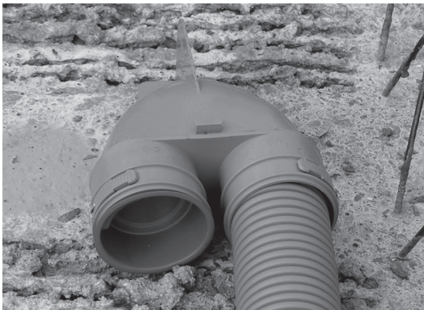
Защита от загрязнения благодаря использованию гигиенических заглушек для всех компонентов
