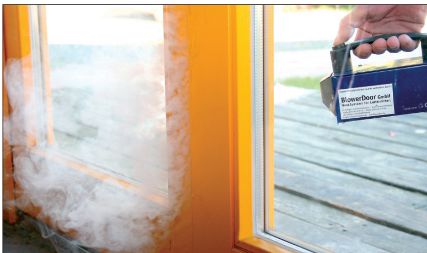
Определение утечек при помощи термодымовой аппаратуры (источник: БлауэрДоор ГмбХ)
